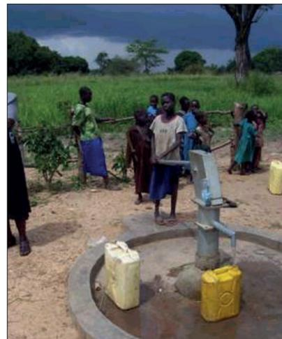
Abb.3: Ein Schachtbrunnen, der von Hand betrieben wird, Obelai, Uganda (© Teso Development Trust www.test.org.uk 45 Sandhurst Avenue, Stourbridge, West Midlands DY9 OXL.)
