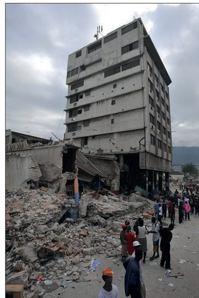
Abb.3: Zerstörte Gebäude im Viertel Bel-Air in Port-au-Prince nach dem Erdbeben 2010 in Haiti. Der hohe Block blieb stehen innerhalb von Ruinen aus niedrigeren, aber schlechter konstruierten Gebäuden. (Photo by Marcello Casal Jr/AB, licensed under the Creative Commons Attribution 2.5 Brazil licence .)
